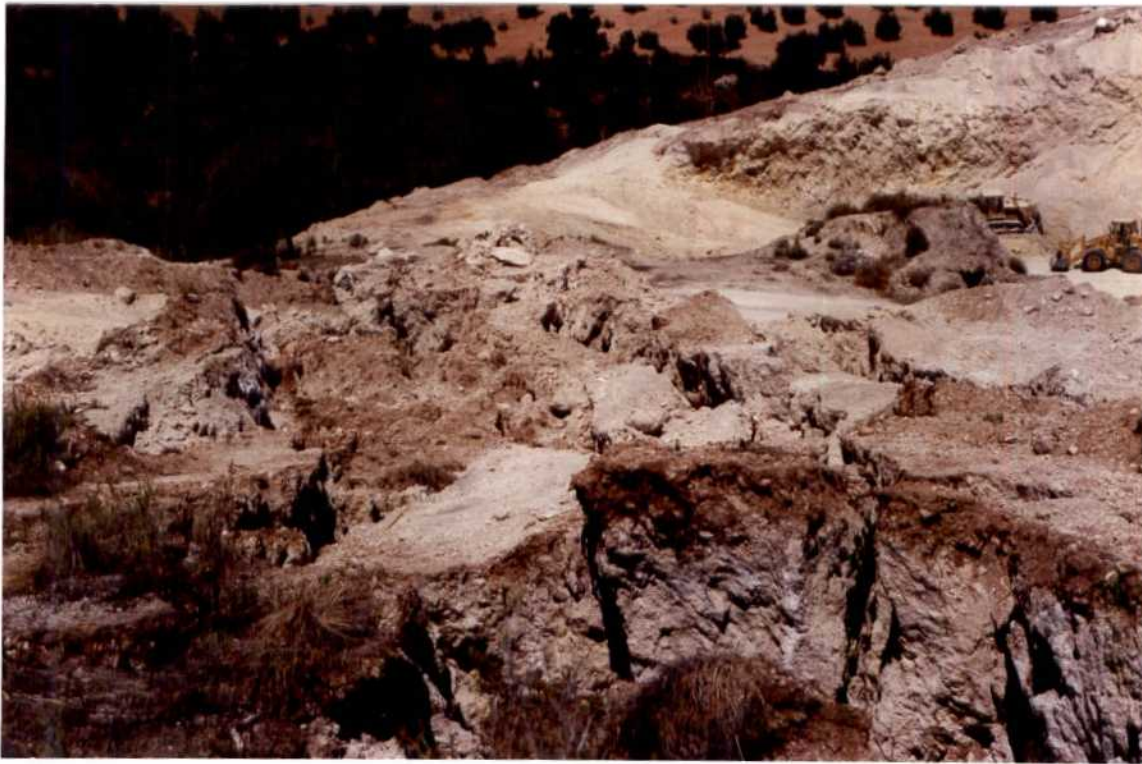
Fotografía nº 11: Agrietamientos paralelos de la parte inferior derecha del deslizamiento, afectando a materiales más deleznales.
